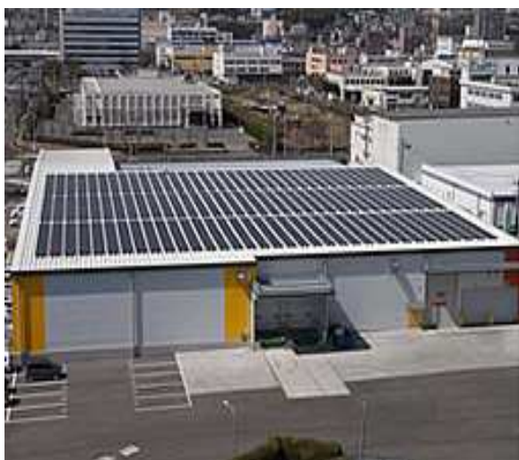
太陽光パネルを設置したフレッシュシステム広島センター
